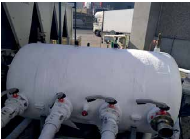
Při výměně chladicí kapaliny během nepřetržitého provozu je často potřeba dočasně použít externího venkovního chlazení.
