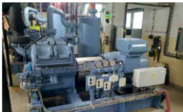
Typický příklad kompresoru, který je nezbytný u absorpčního chlazení
